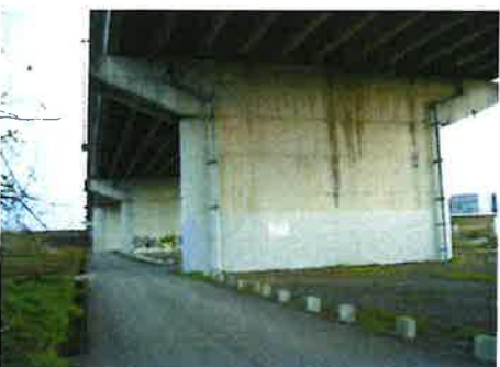
美合橋 橋脚 落書き防止塗装
