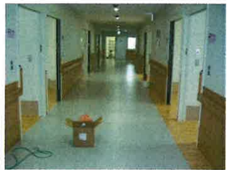
旭川圭泉会病院 新築工事
