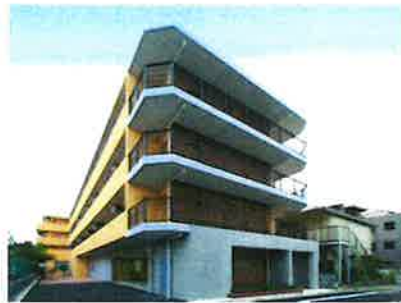
ファミニュー大森南新築工事
