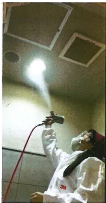
吹きつけコーティング
