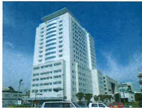
聖マリア病院 国際医療センター 新築工事
