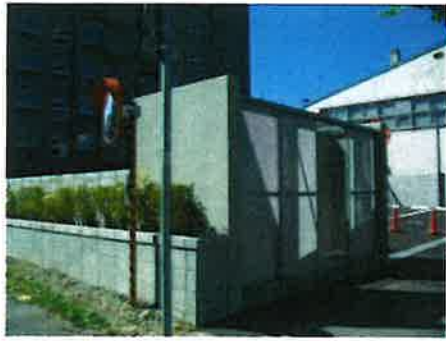
ゴミ置き場 防臭メンテナンス軽減施工
