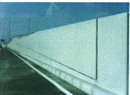
国道23号線 擁壁 落書き防止塗装
