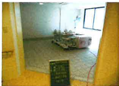
フィロス港新築工事
