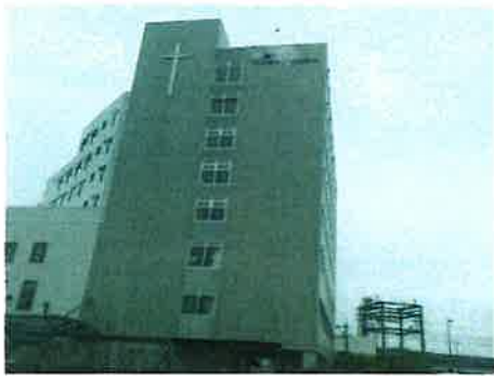
聖マリアヘルスセンター 新築工事
