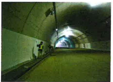
天城北道路 本立野トンネル 視線誘導塗装
