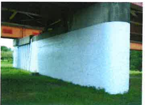
鳴大橋有料道路 橋脚 落書き防止塗装
