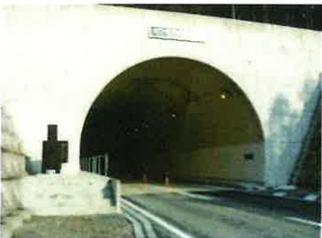
国道421号線 石樽トンネル 視線誘導塗装
